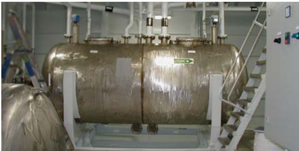
Exempel på uppsamlingstank för oljehaltigt avfall ombord på större fartyg. Motsvarande anordningar kan i princip också anpassas till mindre fartyg. (Källa: DNV)
